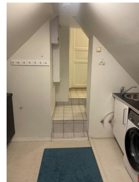
Slange for avrenning av vann, amatørmessig løsning
