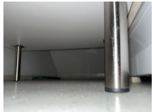
Slange for avrenning av vann, amatørmessig løsning
