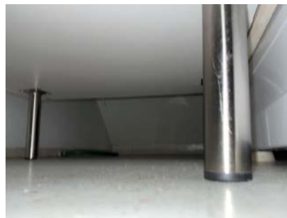
Slange for avrenning av vann, amatørmessig løsning
