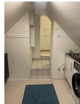
Slange for avrenning av vann, amatørmessig løsning
