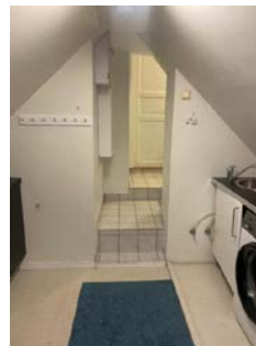
Slange for avrenning av vann, amatørmessig løsning
