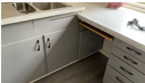
Lav høyde på innredning.
