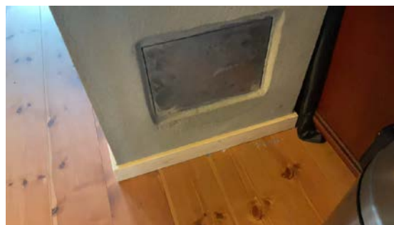
Avstand til brennbart materiale er for kort ihenhold til krav
