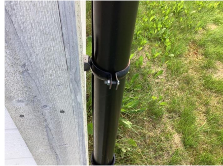
Frostsprengt nedløpsrør.
