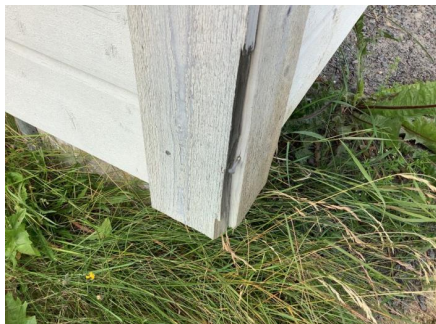
Skadet hjørnekasse.
