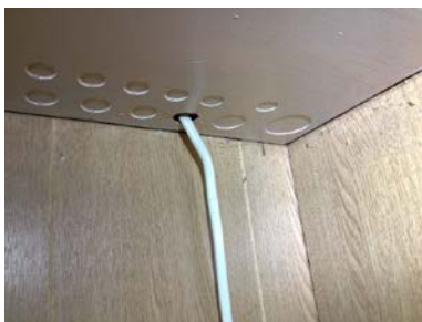
Utett innføring i sikringsskap.
