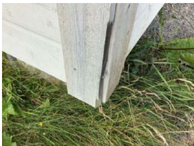
Skadet hjørnekasse.
