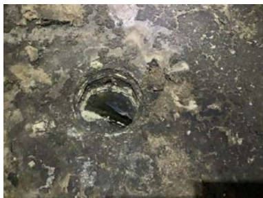
Plastsluk i betonggulv.
