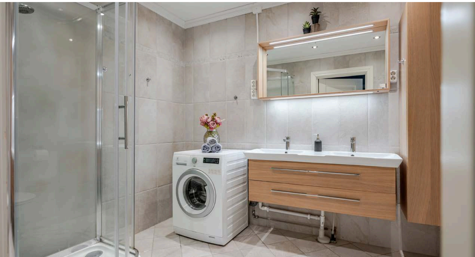
Lyst og innbydende bad/vaskerom fra 2015 i hybeldelen. Baderommet har delikate fliser på gulv og vegger, elektriske varmekabler, downlights i himlingen og balansert ventilasjon. Pen innredning med dobbel servant.
