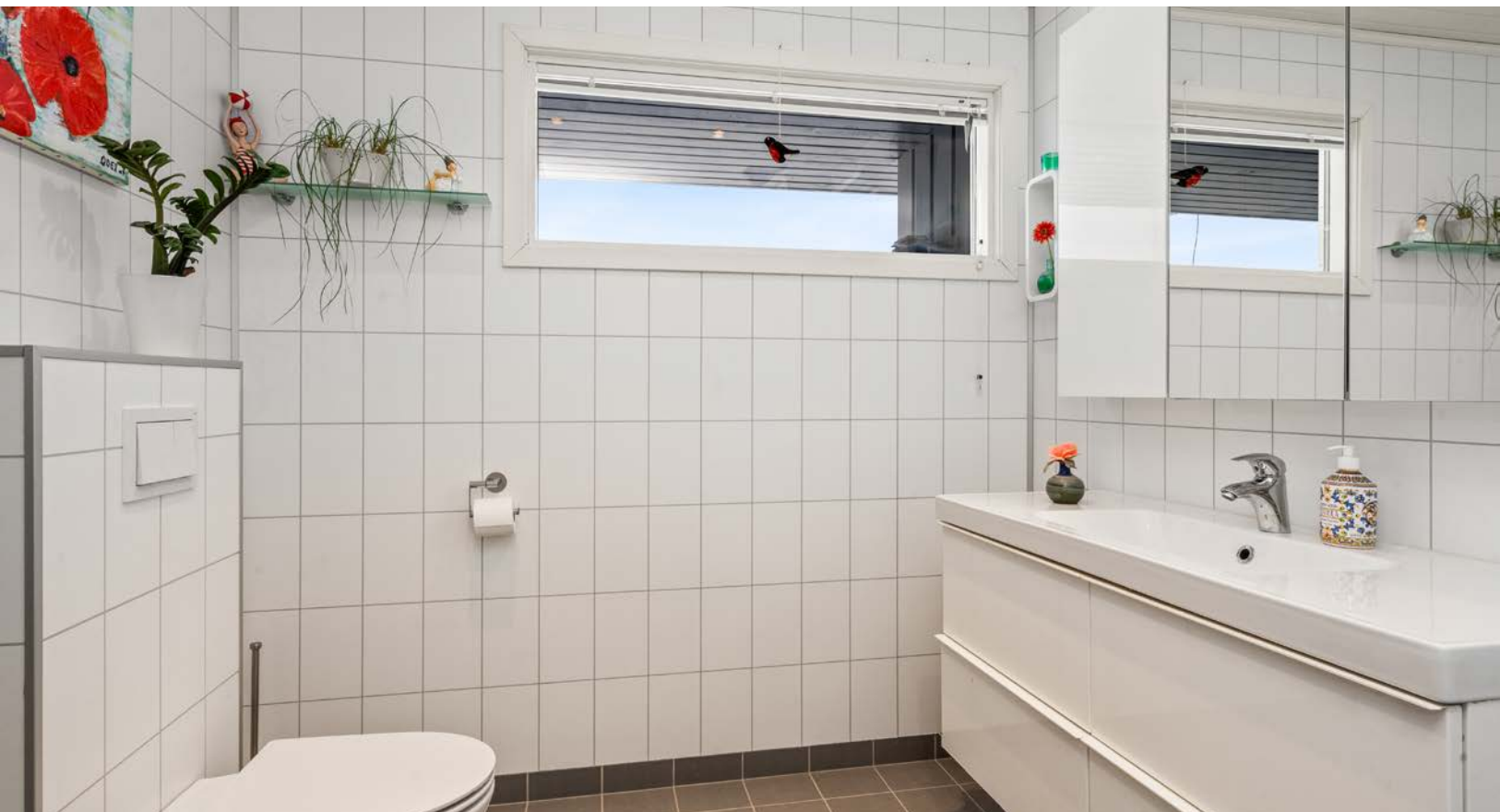
Badet har flislagt gulv og elektriske varmekabler, samt baderomsplater på veggene.
