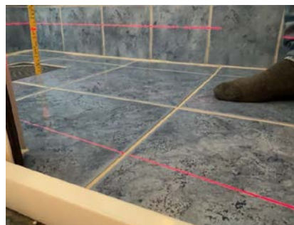
Lite fall mot sluk.
