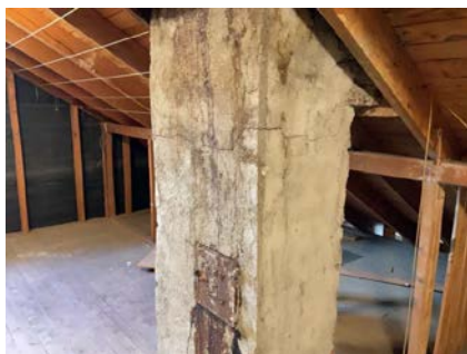
Det er ikke montert ubrennbar plate på gulv under feieluke på kaldloft.
