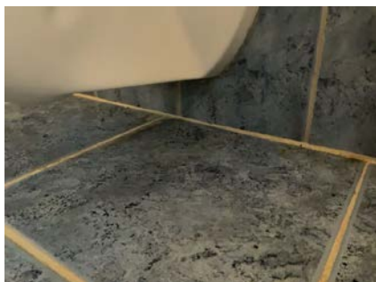
Ingen synlig overløp for skjult systerne.
