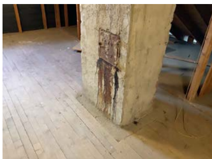
Det er ikke montert ubrennbar plate på gulv under feieluke på kaldloft.
