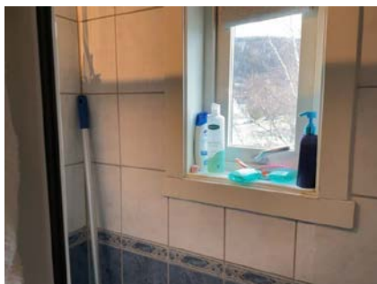
Vindu i dusjsone
