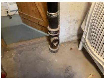
Avløpsrør av soil trolig fra byggeår, ført under betonggulv og ut.
