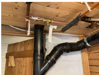
Avløpsrør av soil trolig fra byggeår, ført under betonggulv og ut.
