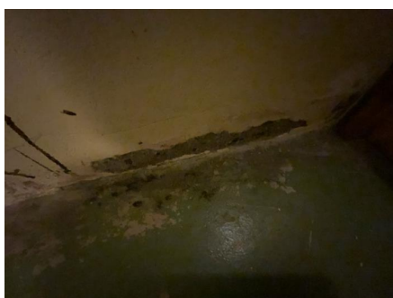
Synlig fukt nederst på grunnmuren og på deler av vegger på vestsiden.
