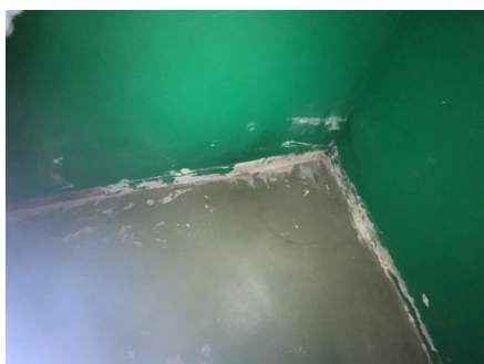
Synlig fukt nederst på grunnmuren og på deler av vegger på vestsiden.
