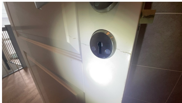
Sprekk ved låsekasse
