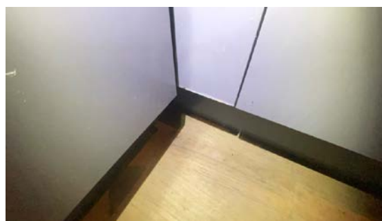
Litt svelling sokkel/passbit hjørne
