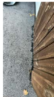
Panel ned i asfaltering- hugget bort asfalt for litt lufting
