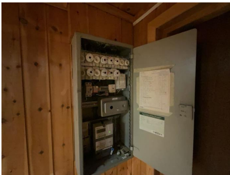
El-anlegget er ikke jordet i tørre rom, dette var normalt på oppføringstidspunktet.
