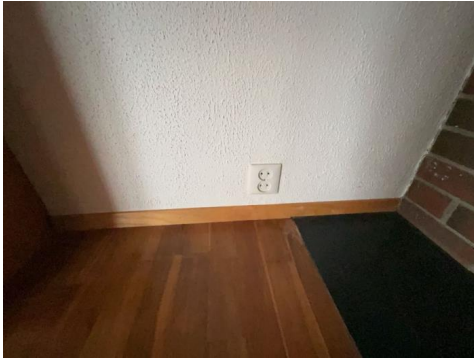
El-anlegget er ikke jordet i tørre rom, dette var normalt på oppføringstidspunktet.
