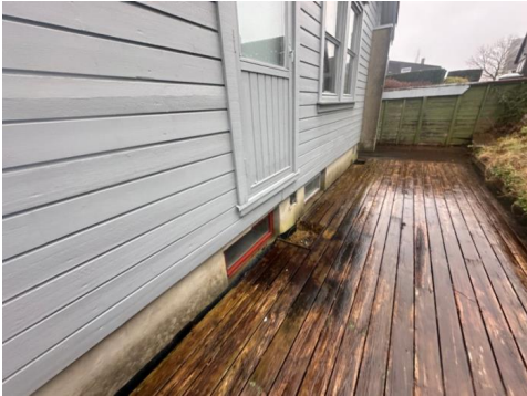
Trapp er demontert.
