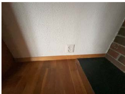
El-anlegget er ikke jordnet i tørre rom, dette var normalt på oppføringstidspunktet.
