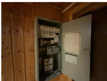
El-anlegget er ikke jordnet i tørre rom, dette var normalt på oppføringstidspunktet.
