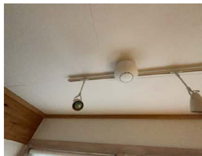
Røykvarsler i 2. etasje var demontert ved befaring.
