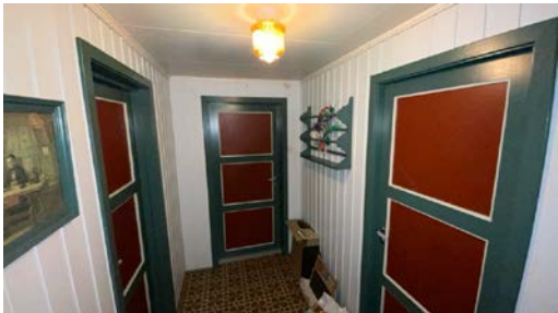
Vaskekjeller, gang med trapp og verksted
