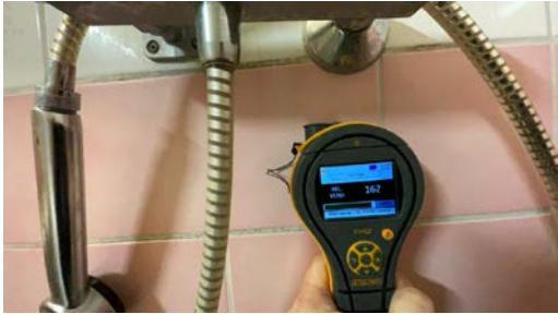
Fuktsøk er utført på vegg i dusj. Ingen forhøyde fuktavvik er målt
