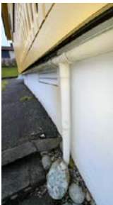
Plast/PVC takrenne på garasjetak ved veranda
