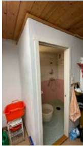
Oversikt dusjrom sett fra vaskekjeller. Betong/mur i omkringliggende vegger
