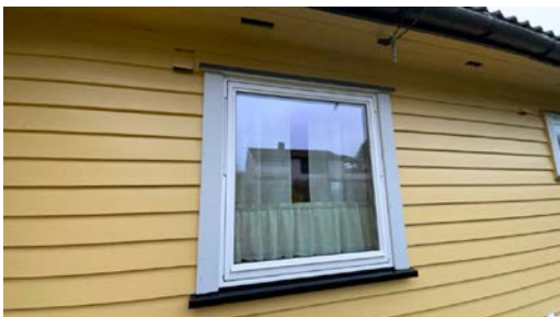
Vindu på kjøkken fra 2013
