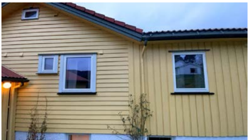
Vindu på soverom og bad fra 2014
