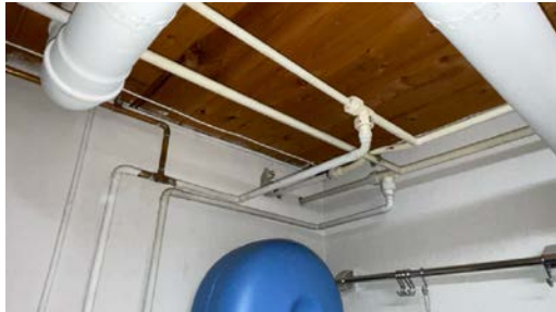
Eldre åpne rør i himling på vaskekjeller
