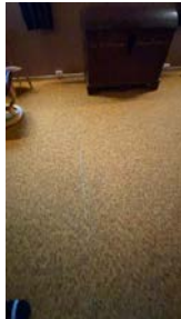
Synlig skjøt på teppe i kjellerstue
