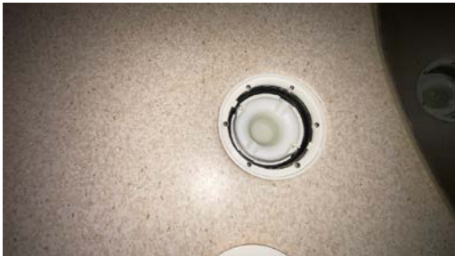
Vinylbelegg er ført ned under klemring i sluk.
