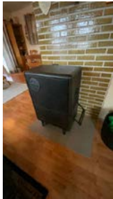
Vedovn i stue 1. etasje. Fliser under ligger løst på gulvet.
