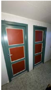
Dører til boder sett fra gang med trapp
