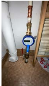
Hovedstoppekrane med vannmåler
