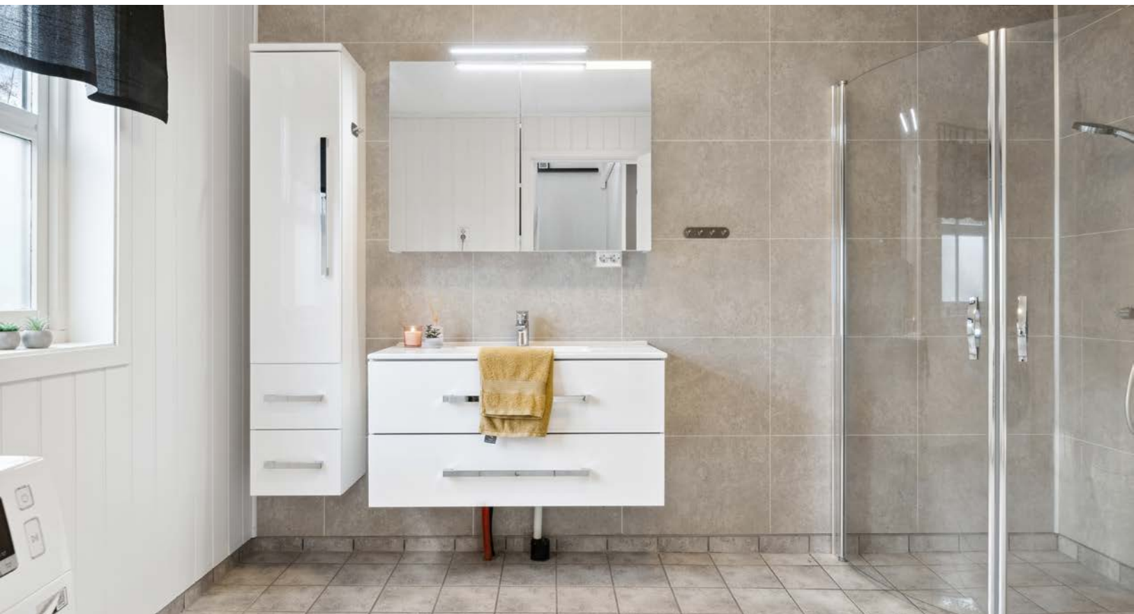
Bad ble oppgradert i 2018. Baderomsvifte og nytt blanderbatteri dusj fra 2024. Badet har flis på gulv med gulvvarme, våtromsplater og malt overflate på vegger.
