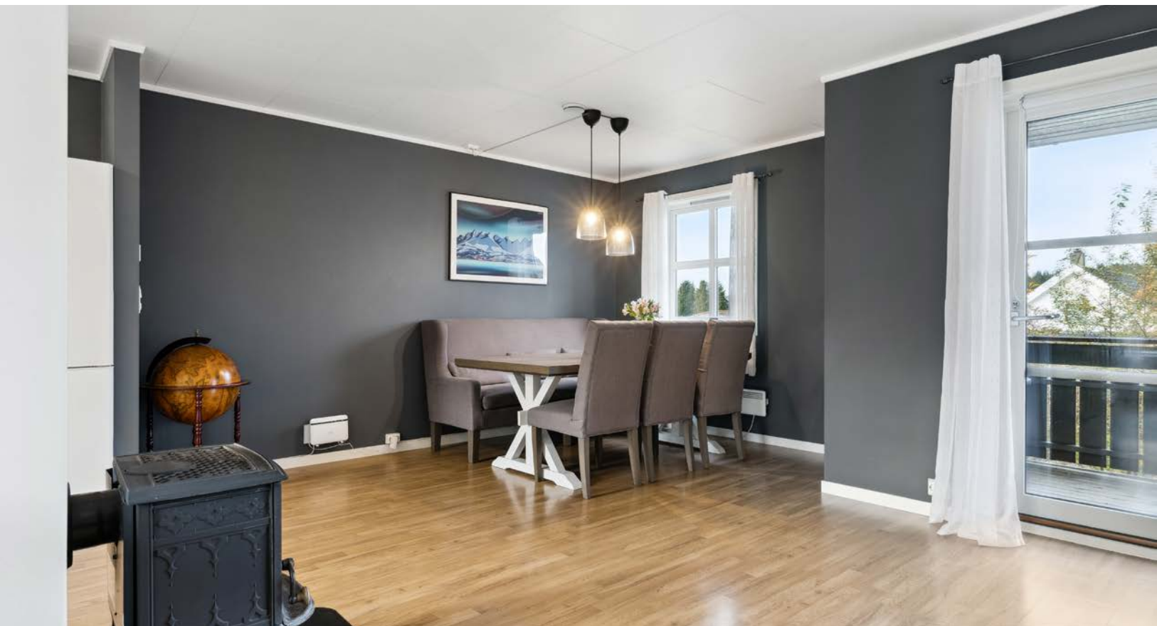
Nytt ventilasjonsanlegg fra 2024
