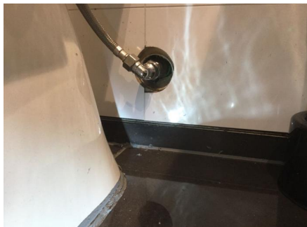
Utettheter i membran rundt rørgjennomføringer.
