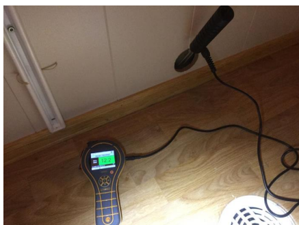
Ved fuktmåling registrerte jeg tørre verdier.
