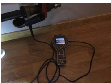
Hulltaking utført fra tilstøtende rom.
