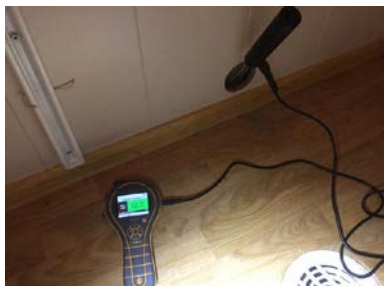
Ved fuktmåling registrerte jeg tørre verdier.
