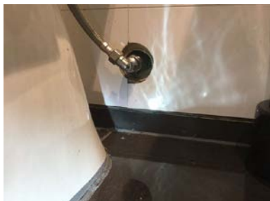
Utettheter i membran rundt rørgjennomføringer.
