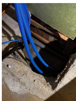
Luke til krypkjeller helt oppunder taket
