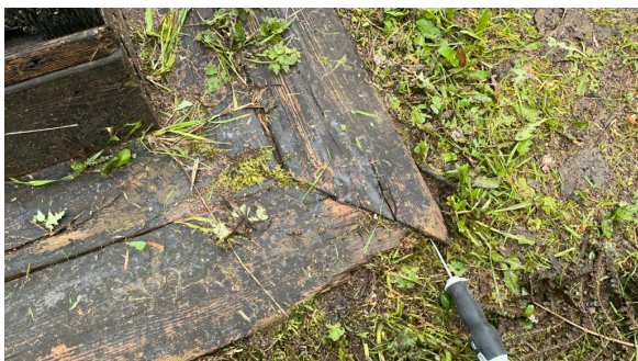
Eksempel på slitasje.
