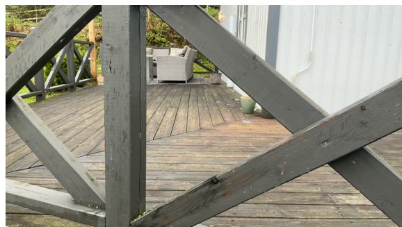
Åpninger i rekkverk er ikke i henhold til krav i dagens forskrifter.
