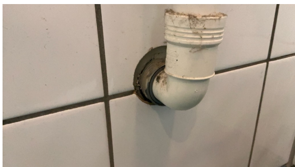
Det er registrert utette rørgjennomføringer i vegg
