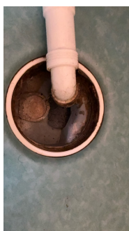
Det er registrert utette rørgjennomføringer i vegg
