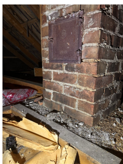
Ildfast plate mangler på gulvet under sotluke/feieluke på pipe.
