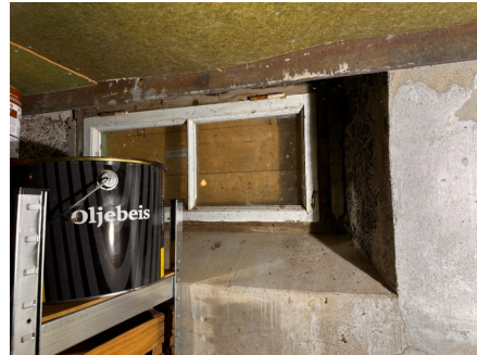
Vindu (1) mot tilbygg
