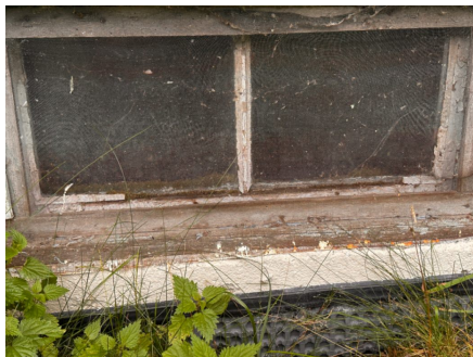
Vindu (2) fra utsiden
