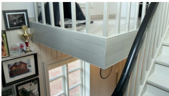
Manglende søyle under etasjeskille
