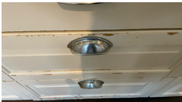
Overflateskader/svelling
