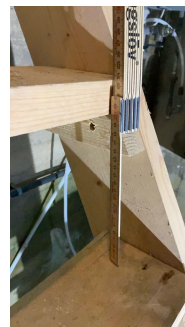
Åpninger mellom trinn i innvendig trapp er større enn dagens forskriftskrav.
