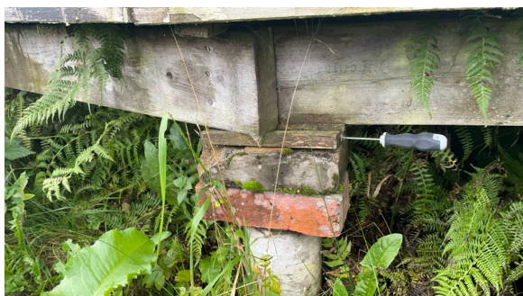
Et av søylefundamentene
