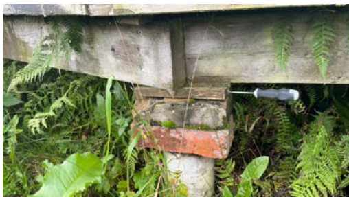
Et av søylefundamentene
