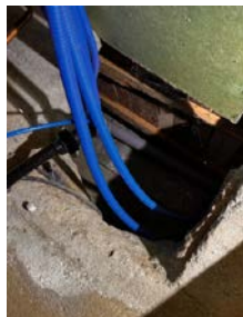
Luke til krypkjeller helt oppunder taket
