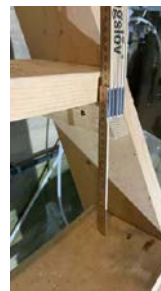
Åpninger mellom trinn i innvendig trapp er større enn dagens forskriftskrav.
