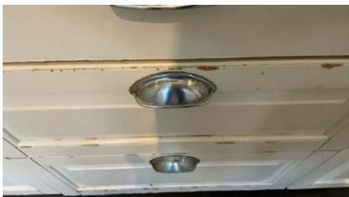
Overflateskader/svelling
