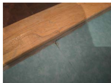
Hull i gulvbelegg med dør
