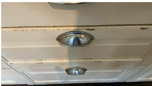
Overflateskader/svelling
