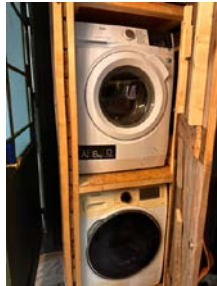
Vaskemaskin og tørketrommel i skap i entré
