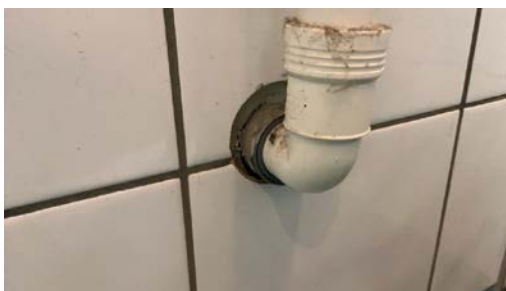
Det er registrert utette rørgjennomføringer i vegg
