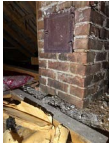
Ildfast plate mangler på gulvet under sotluke/feieluke på pipe.
