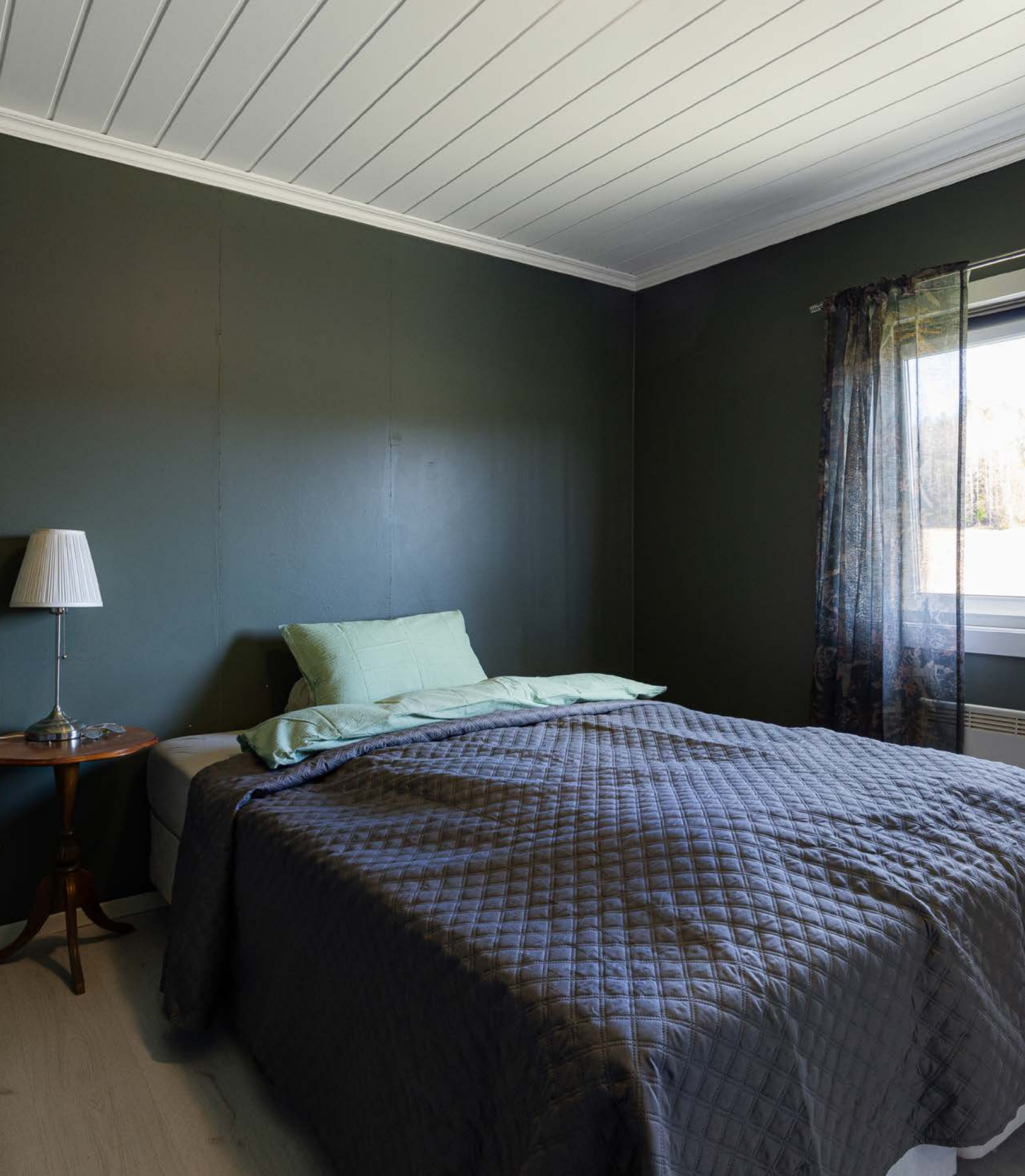
Kårboligen har to soverom. Bildet viser det minste rommet. Soverommene i kårboligen har for liten dagslysflate i forhold til dagens krav.
