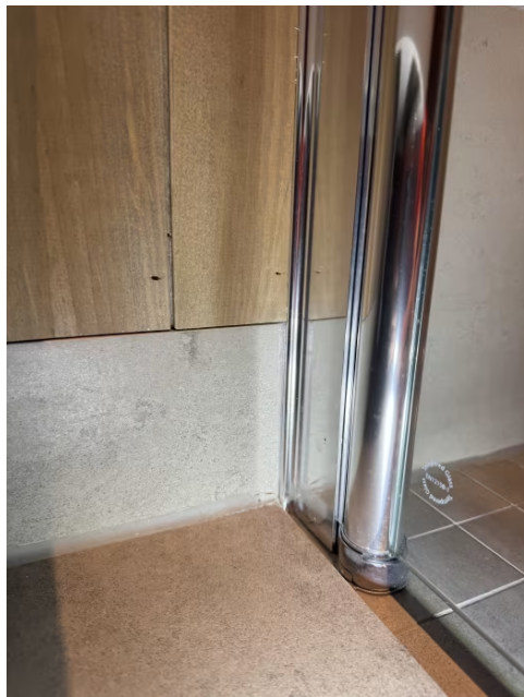
Panel i våtsone men ingen fuktskader.
