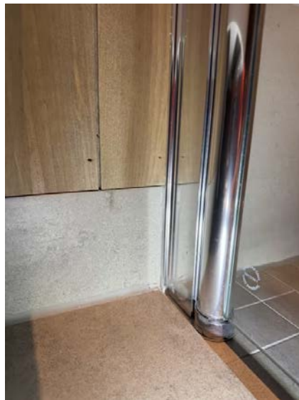
Panel i våtsone men ingen fuktskader.
