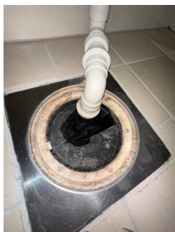
Sluk i plast, plassert under servanskap
