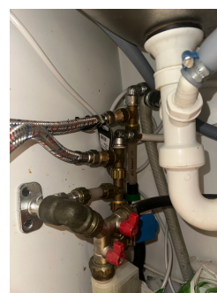
Røropplegg i kjøkkenbenk med Waterguard
