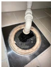
Sluk i plast, plassert under servanskap
