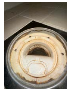
Sluk i plast, plassert i dusjnisje
