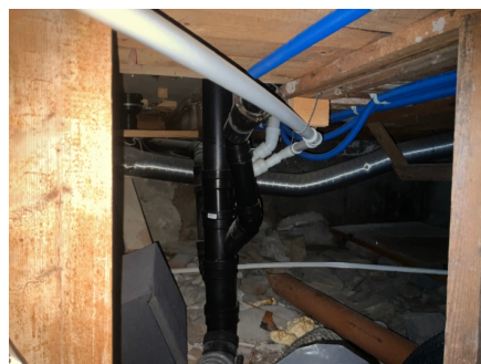
Sorte rør av nyere dato, grå rør eldre dato.
