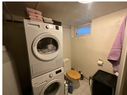
Ventilering ved åpning av enkelt ruta glass.
