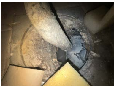
Eldre sluk uten synlig membran.
