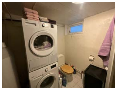
Ventilering ved åpning av enkelt ruta glass.
