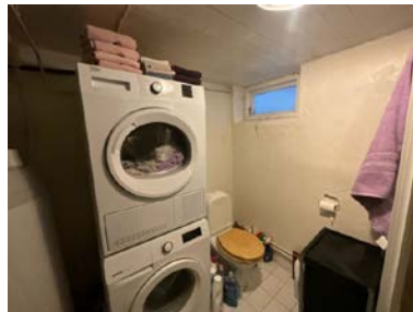
Ventilering ved åpning av enkelt ruta glass.
