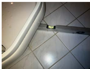
Flere sprekker i gulvet.
