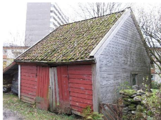
Figur 20. Sett mot sør.
