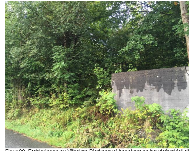
Figur 39. Etableringen av Vilhelms Bjerknesvei har skapt en høydeforskjell til gamle Slettebakkvei. Det er satt opp en betongmur der veien en gang kom ned. Det er fylt inntil muren i bakkant med grove masser. Til venstre for betongmuren ses det siste lindetreet i rekken av 15.
