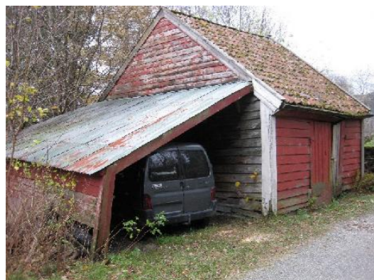
Figur 19. Vognskjulet, sett mot vest
