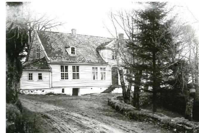
Figur 12. Fasaden mot nord. Bildet er udatert men antakelig fra perioden 1890 til 1910. De senere foto og oppmålinger fra 1926 viser 1700-tallsvinduer på hele fasaden. Vinduene like øst for inngangsdørene vises her som en 1800-tallstype. Lauritz Bekker Larsen. Billedsamlingen UiB.
