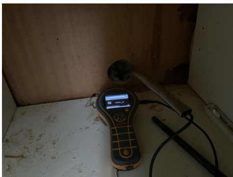
Hulltaking i kjøkkenskap
