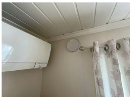
Lufteventil i stuen
