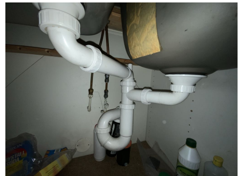
Besiktigelse av røropplegg.
