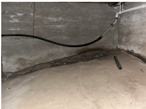
Avløpsrør fra kjøkken
