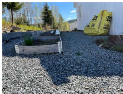
Terreng med noe fall mot grunnmur
