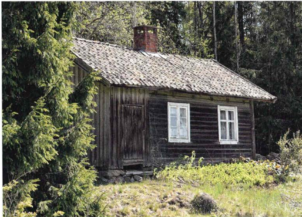
Sørli i Tyrihjellveien 235 er en godt bevart småkårsbygning, trolig fra midten av 1800-tallet.
