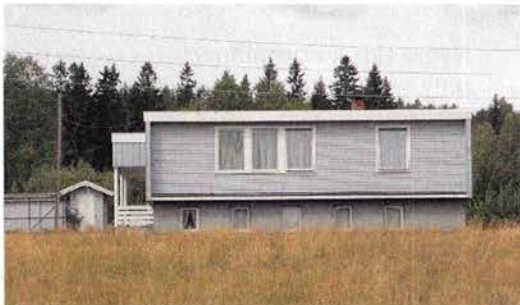
Modernistisk villa i Fosserveien 250.
