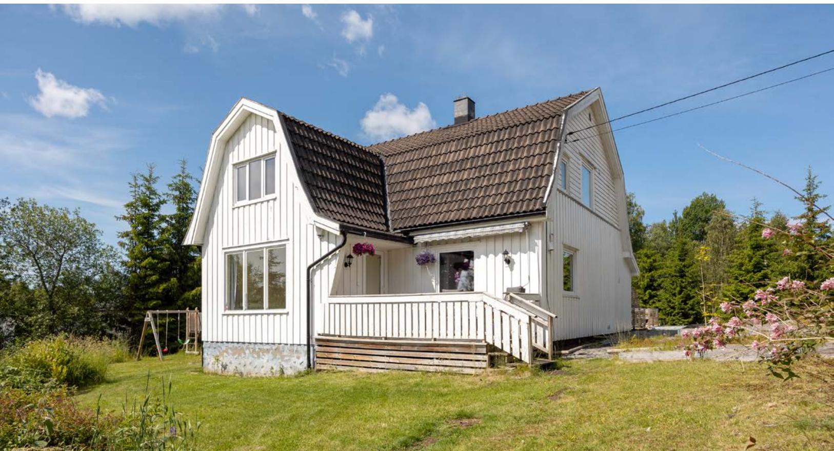
Det er rikelig med trygg boltreplass i den store, solrike hagen.
