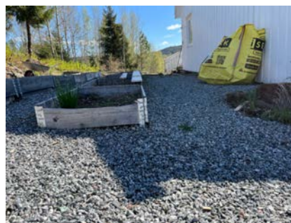
Terreng med noe fall mot grunnmur
