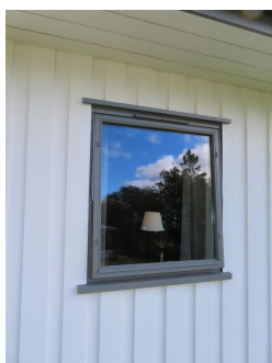
Eksempel på åpningsvindu. H-vinduet med palteventil i overkarm.
