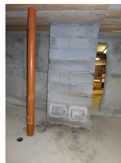
Sotluke i kjeller på pipe i kjøkken/spisestuedel.
