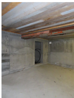
Deler av kjellerrom. Ingen påviste avvikende forhold som hindrer bruk som bygd.
