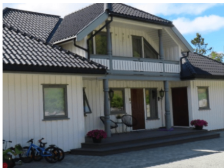
Overbygd inngangsparti med hovedadkomst dør samt dør inn til vaskerom. Leddport/kjørestor port til kjellerrom. Begge som utadlående. Øvrige dører i bygget som terrassedører.
