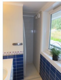
Del av dusjbad - dusjnise med lettvegg mot servantskap.
