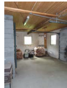
Ytre garasjerom med adkomst via leddport.
