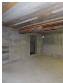
Deler av kjellerrom. Ingen påviste avvikende forhold som hindrer bruk som bygd.
