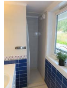
Del av dusjbad - dusjnisse med lettvegg mot servantskap.
