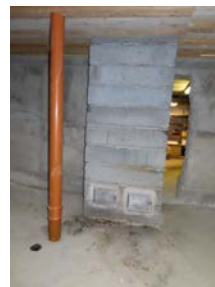
Sotluke i kjeller på pipe i kjøkken/spisestuedel.
