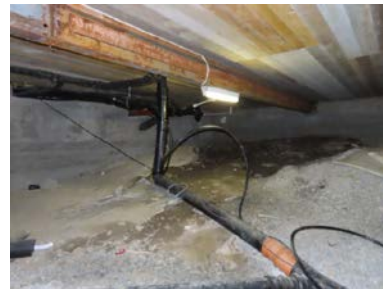
Del av åpent etablert avløpsrør.
