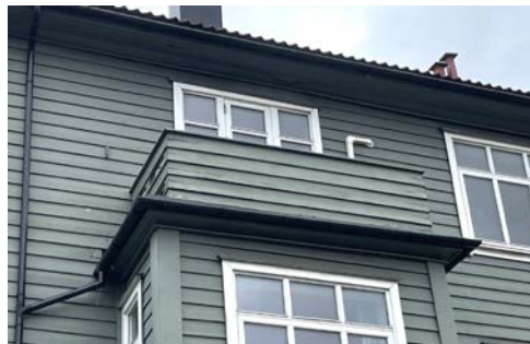
Balkong sett fra bakken
