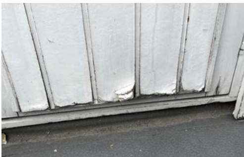
Fuktskadet balkongdør
