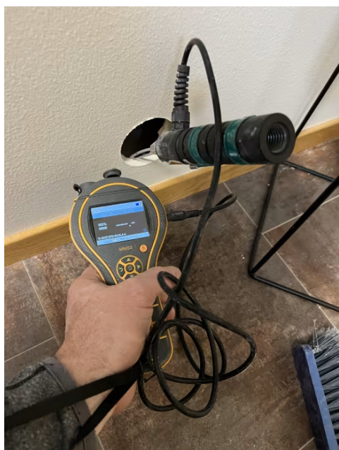
Det ble ikke registrert fukt.
