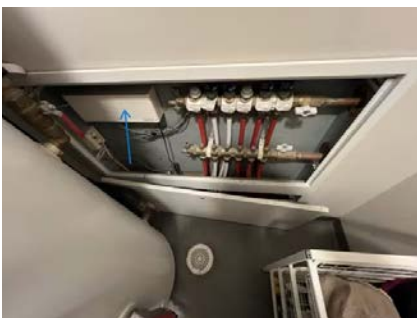
Samleskap, defekt styringsenhet.
