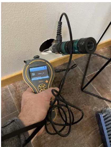
Det ble ikke registrert fukt.
