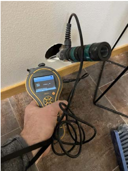
Det ble ikke registrert fukt.
