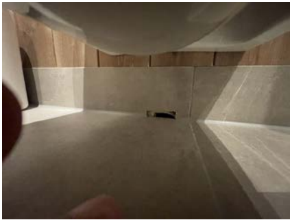
Hull for synliggjøring av lekkasjevann fra innebygget systerne.
