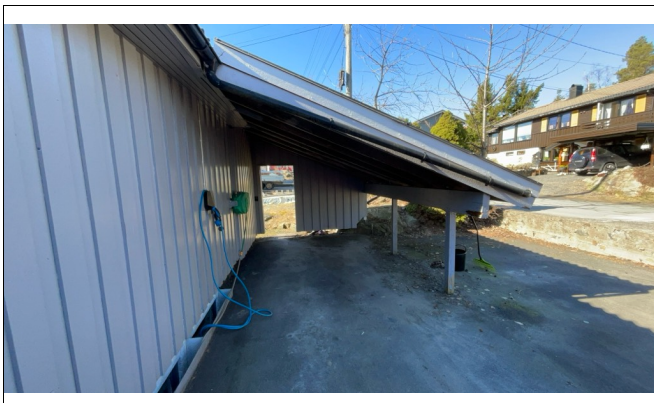
Carport i forbindelse med gårds plass.
