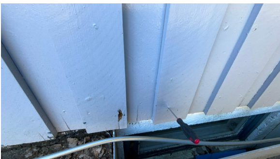
Stikk kontroll av vegger er utført. Del av vegg.
