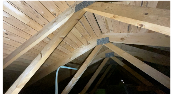
Del av takkonstruksjon, sett fra loft.
