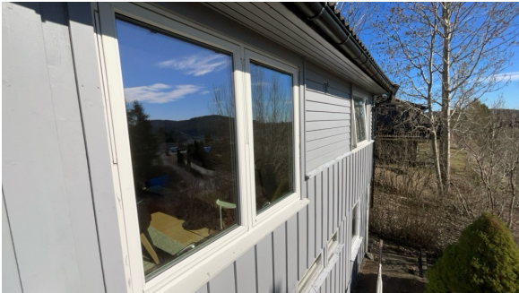
Eksempel på vindu i yttervegg.
