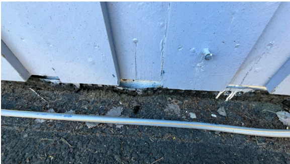
Del av grunnmur.
