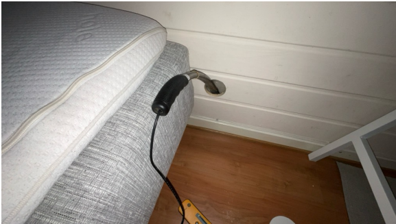
Hull for kontroll av fukt.
