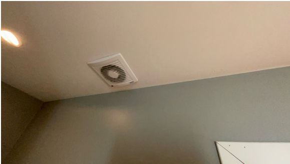
Montert avtrekk i tak.
