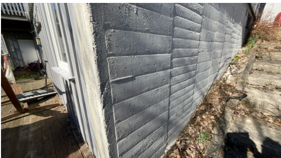
Del av grunnmur.
