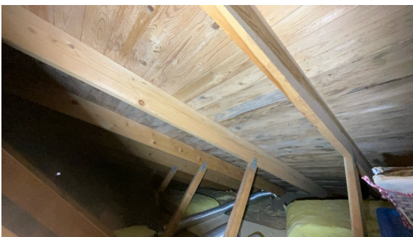
Del av takkonstruksjon, sett fra loft.
