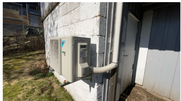
Varmepumpe ytterdel.
