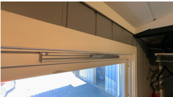
Eksempel på montert ventil i vindu.
