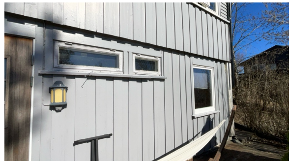
Eksempel på vindu i yttervegg.
