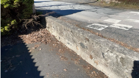
Del av forstøtningsmur.
