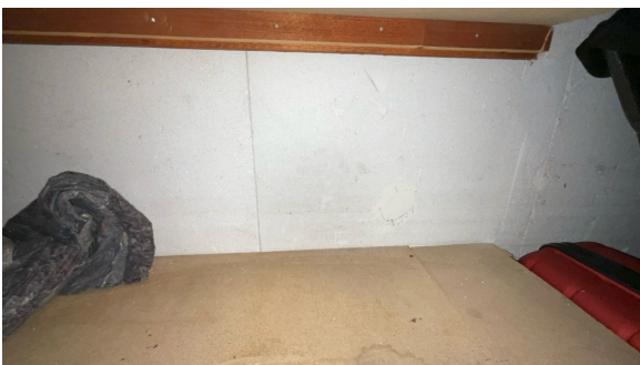
Del av rom under terreng.
