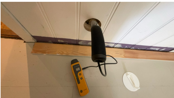
Hull for kontroll av fukt.
