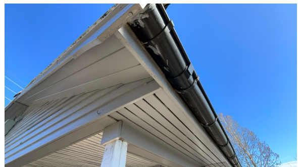
Del av takkonstruksjon.
