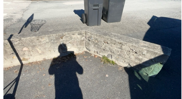
Del av forstøtningsmur.
