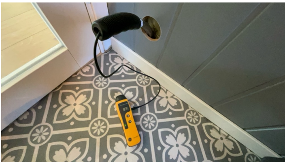
Hull for kontroll av fukt.
