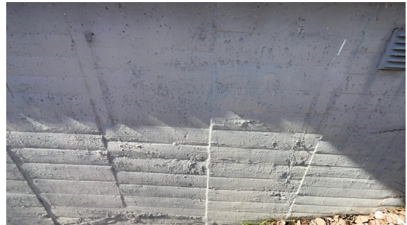
Del av grunnmur.
