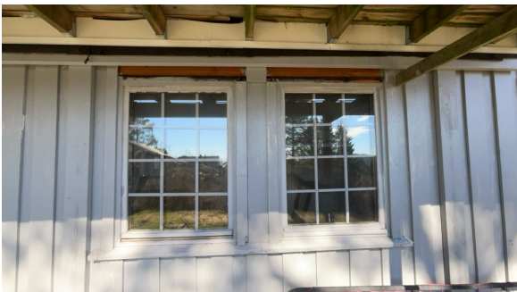
Eksempel på vindu i yttervegg.
