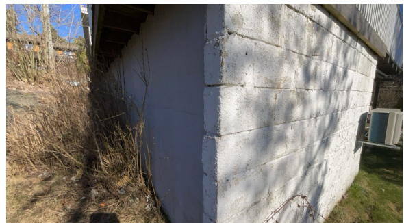
Del av grunnmur.
