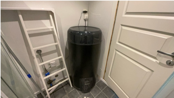
Varmtvannstank.
