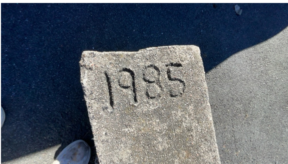
Del av forstøtningsmur.
