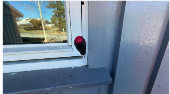
Stikk kontroll på vinduer er utført.
