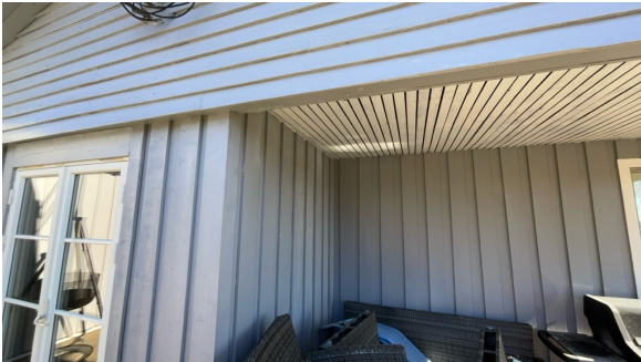
Del av vegg.
