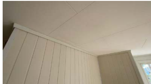
Del av vegg - tak.
