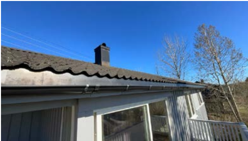
Del av taktekkning.
