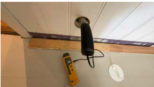
Hull for kontroll av fukt.
