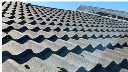
Del av taktekkning.
