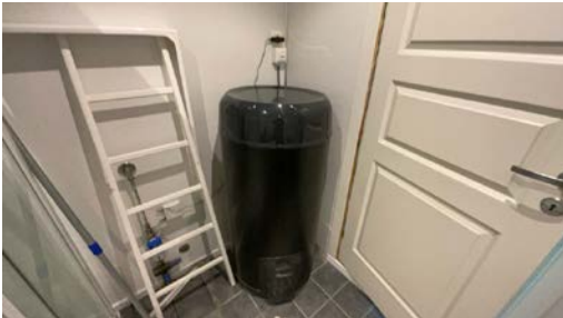
Varmtvannstank.
