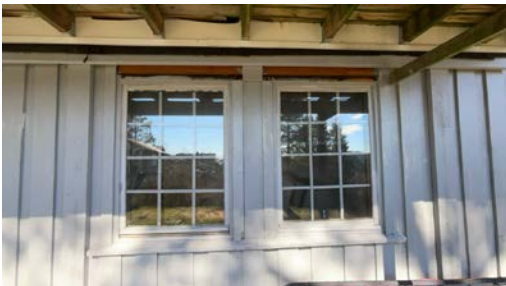
Eksempel på vindu i yttervegg.
