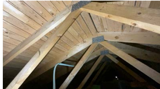
Del av takkonstruksjon, sett fra loft.
