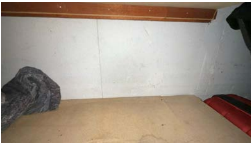
Del av rom under terreng.
