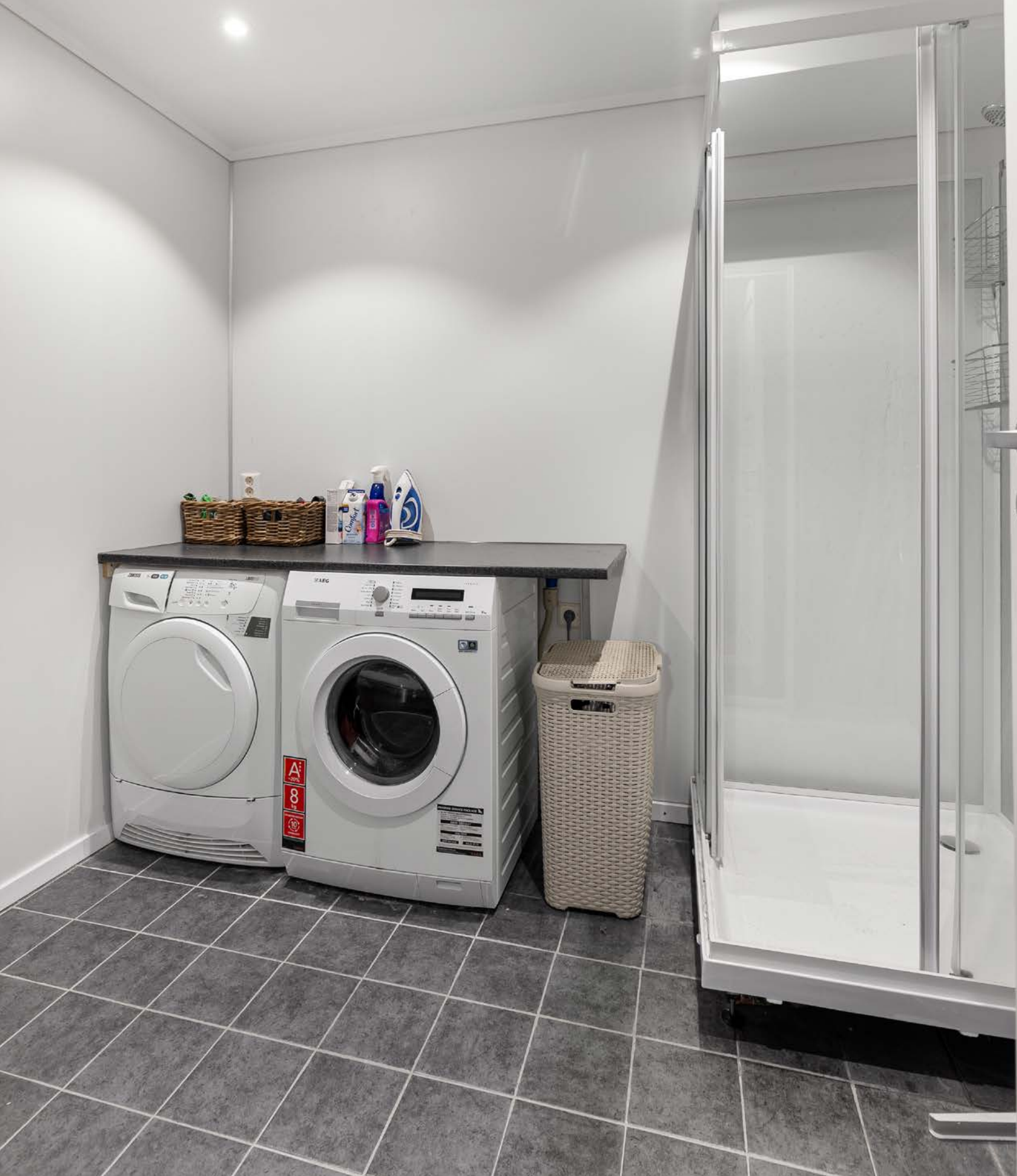
Vaskerommet har flislagt gulv med varmekabler og plater på vegger. Rommet har dusjkabinett og opplegg til vaskemaskin.
