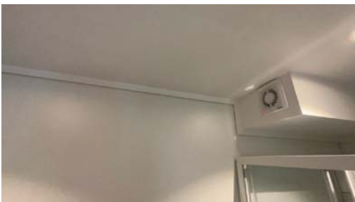
Del av vegg - tak.
