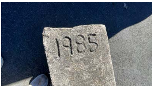
Del av forstøtningsmur.
