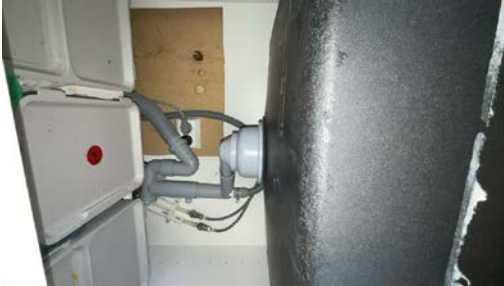
Del av rør til avløp.
