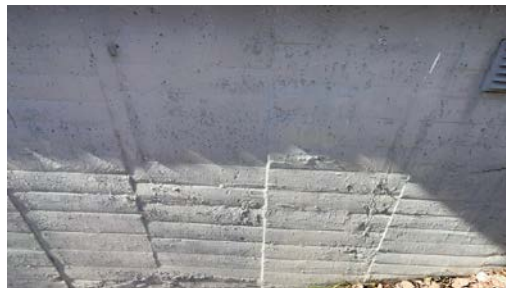
Del av grunnmur.
