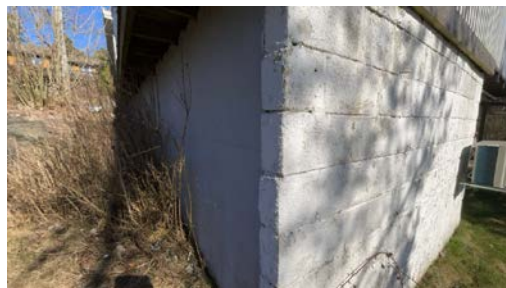
Del av grunnmur.
