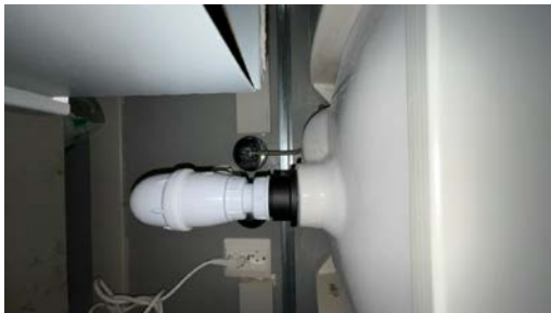
Del av rør til vann.
