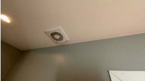
Montert avtrekk i tak.
