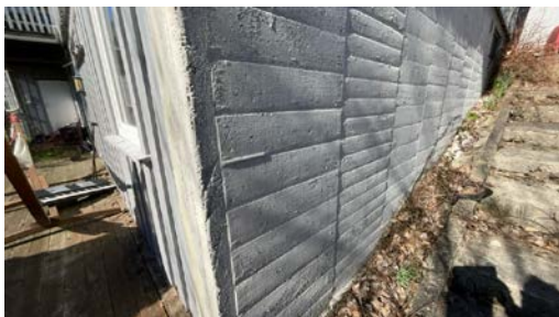
Del av grunnmur.
