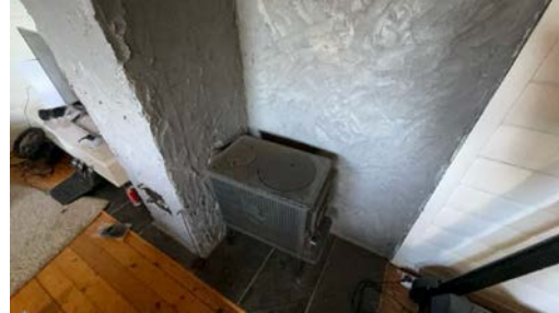
Montert ovn i stue.
