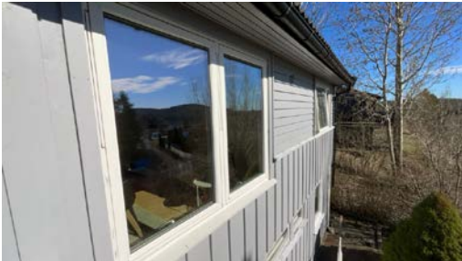
Eksempel på vindu i yttervegg.
