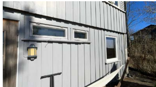
Eksempel på vindu i yttervegg.
