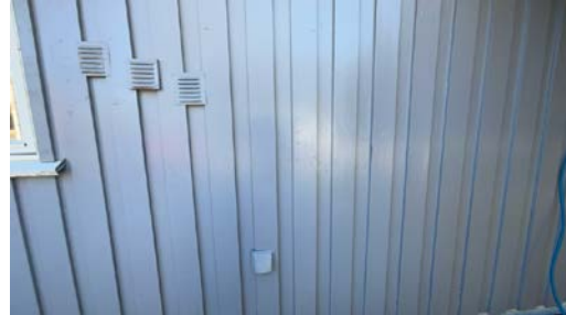
Del av vegg.
