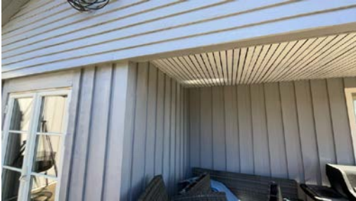
Del av vegg.
