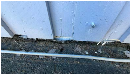
Del av grunnmur.
