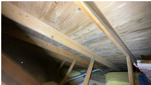
Del av takkonstruksjon, sett fra loft.
