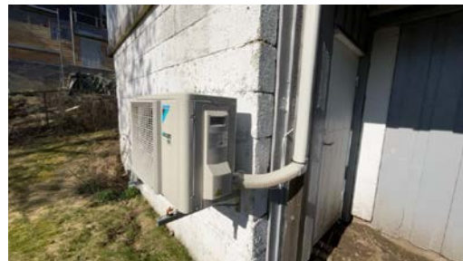
Varmepumpe ytterdel.
