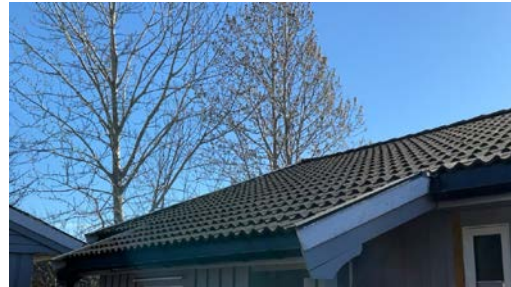
Del av taktekkning.
