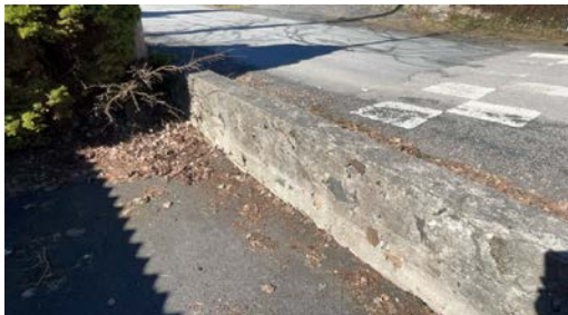
Del av forstøtningsmur.
