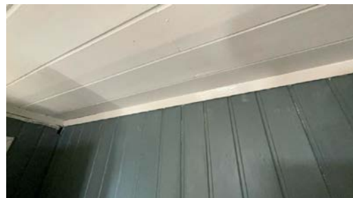
Del av vegg - tak.
