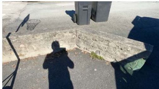
Del av forstøtningsmur.
