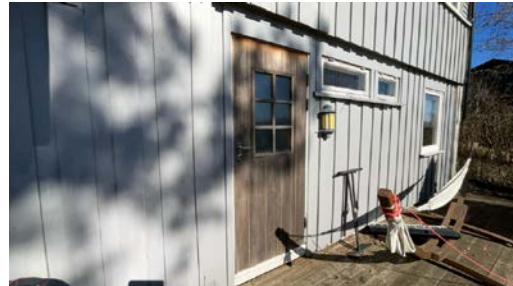
Dør inn til underetasjen.
