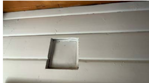
Eksempel på montert ventil i vegg.
