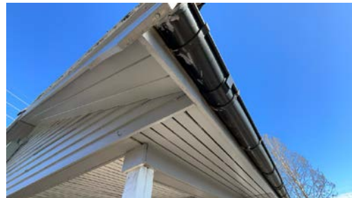
Del av takkonstruksjon.
